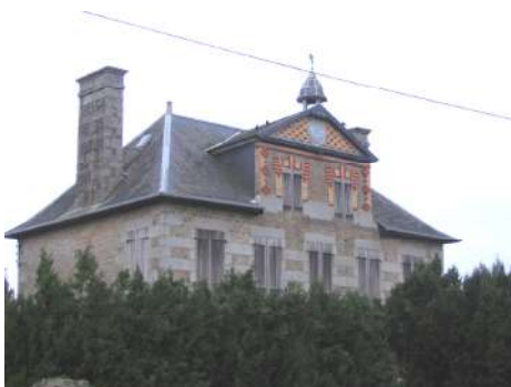
bâti ancien à vocation patrimoniale
